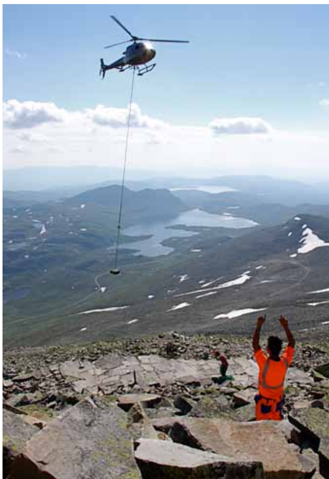
Nima gir piloten beskjed om hvor steinene skal plasseres.
